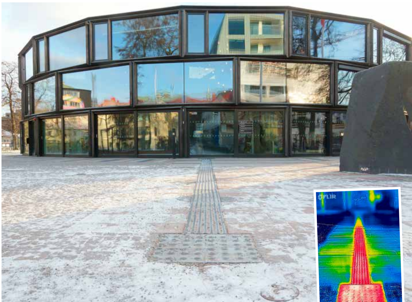
Vid Orangeriet i Borås hålls den taktila markeringen is- och snöfri med hjälp plattor av konduktiv komposit och klenspanning. Bilden tagen med värmesensor visar temperaturskillnaden.
